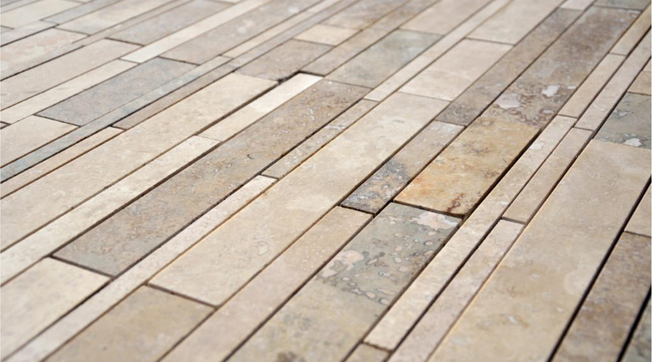
Das Mosaik aus **Travertinstreifen in verschiedenen** Größen ergibt zusammen angeordnet eine Fläche wie in der Antike. Die Leisten werden in verschiedenen Farben ausgesucht und dann auf Matten vormontiert, um das Verlegen zu erleichtern.
